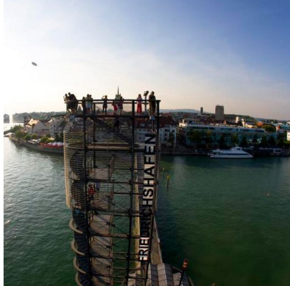
Der 22 Meter hohe Moleturm an der Promenade – © Stadt Friedrichshafen
